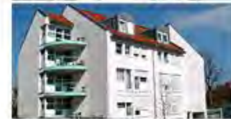
Wohnheim AA-Unterrombach, Steinertgasse 10
